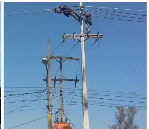
Adecuación de red de MT y BT a Protegida y Preensamblada en los Alimentadores de los Centros de Distribución San Lorenzo, La Victoria y Capiatá, en el Dpto. Central Licitación Pública Nacional ANDE N° 1036/2014 – Lotes 1 y 4 - BONOS I
